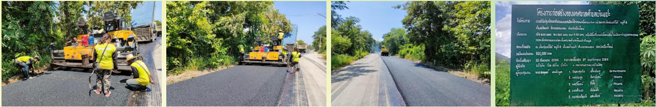
โครงการงานปรับปรุงซ่อมแซมถนนแอสฟัลต์คกริตแบบ Over Lay สายทางบ้านม่วงเปาใต้ หมู่ที่ 6 ตำบลบ้านแปะ อำเภोजอมทอง จังหวัดเชียงใหม่
