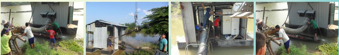
โครงการซ่อมแซมสถานีสูบน้ำด้วยไฟฟ้าบ้านสบเปะ 3
