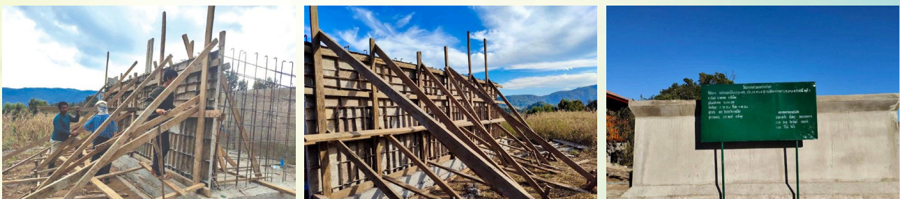
โครงการก่อสร้างถึงพิกน้ำดิบประปาภูเขา บ้านต้นผึ้ง หมู่ที่ 17
