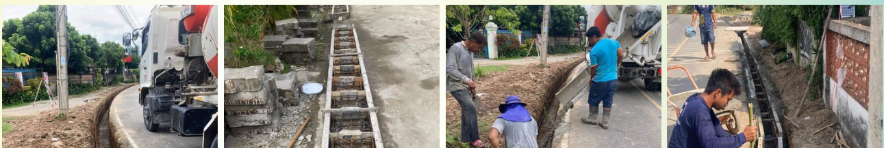
โครงการก่อสร้างระบบน้ำคอนกรีตเสริมเหล็กสายทางบ้านนายอูบ แก้วคำสุ - โรงเรียนบ้านห้วยทราย หมู่ที่ 5
